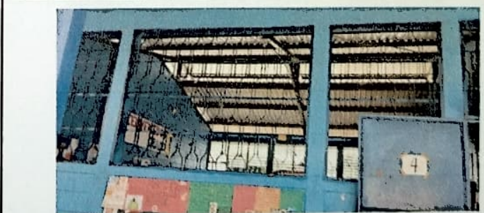
Foto 6: Mantenimiento de balcones de metal (lijado y pintura)
