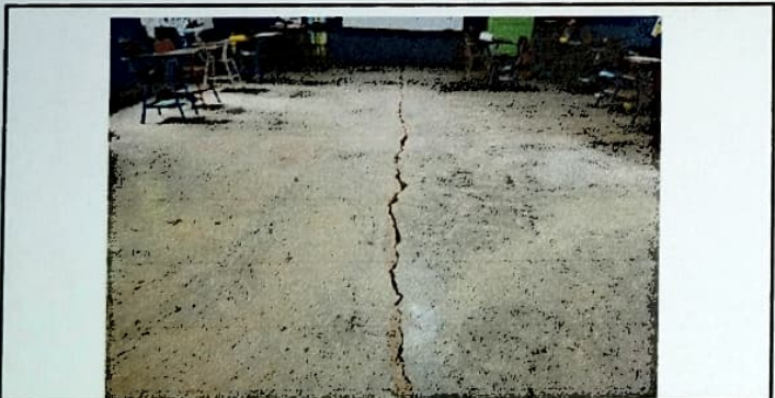
Foto 9: Sustitución de piso de cemento liquido por ceramico modulo 3
