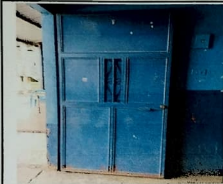
Foto 1: mantenimiento de puerta (lijado y pintura)
