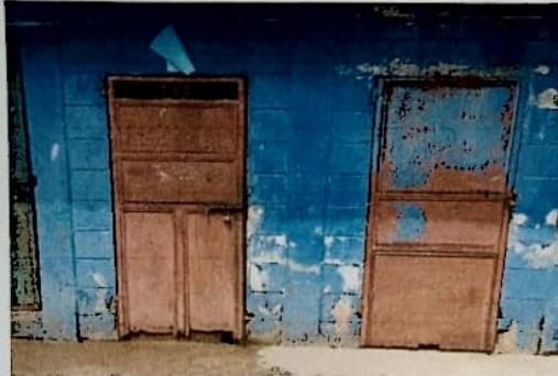
Foto13: Fabricación e instalación de puerta de metal de baños
