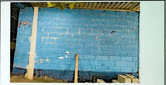
Foto 10 : Pintura de muros de exteriores modulo 4
