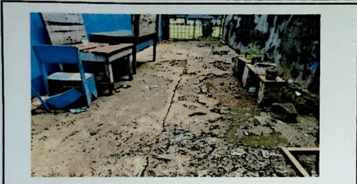
Foto7: Reparacion de piso de torta de concreto modulo 3
