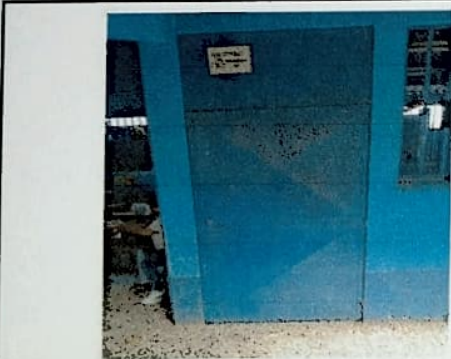
Foto 3: mantenimiento de puerta (lijado y pintura)
