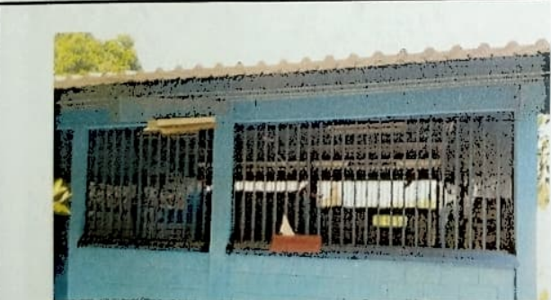
Foto 5: Mantenimiento de balcones de metal (lijado y pintura)
