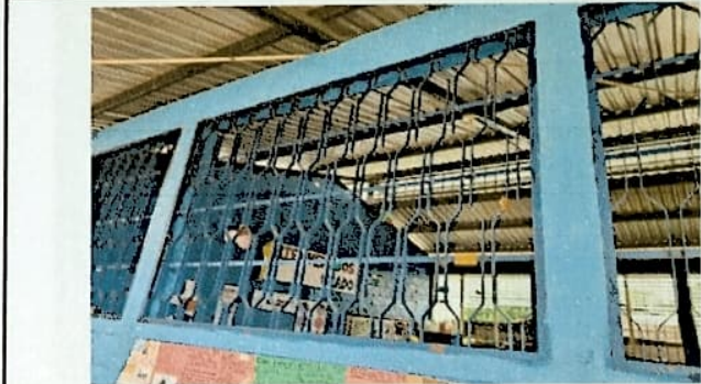
Foto 4: Mantenimiento de balcones de metal (lijado y pintura)
