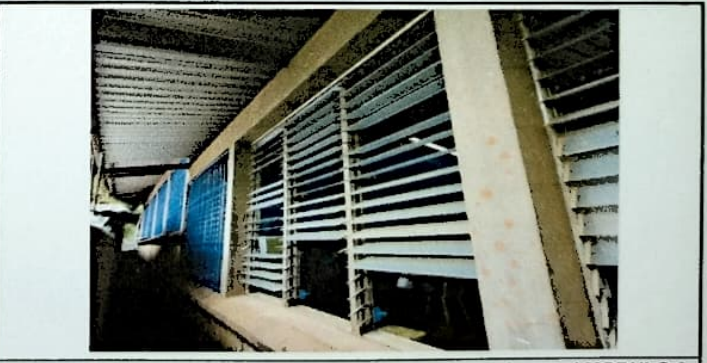
Foto 12: Fabricación e instalación de ventana-balcon de metal MODULO 2
